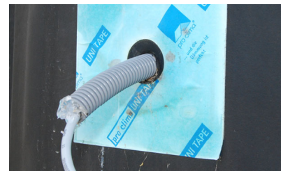
Abdichtung Kabeldurchführung
