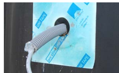
Abdichtung Kabeldurchführung
