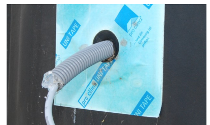
Abdichtung Kabeldurchführung
